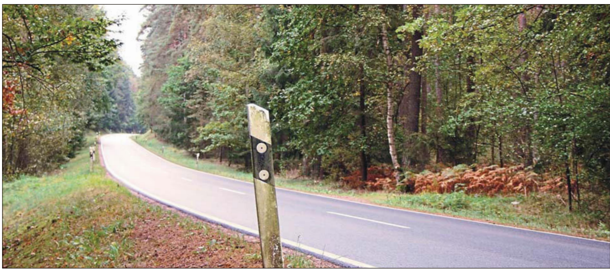
Auf der engen und unübersichtlichen Straße zwischen Strahlfeld und Oberkreith passieren immer wieder Unfälle. Die Bevölkerung wünscht einen Ausbau, wobei auch ein Radweg angelegt werden sollte.
