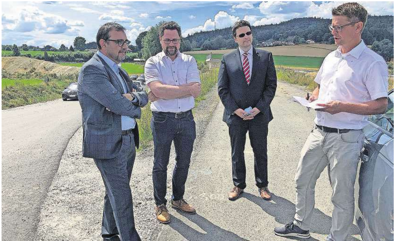
Dr. Richard Bosl (r.) gab Staatssekretär Klaus Holetschek, MdL Dr. Gerhard Hopp und Bürgermeister Dr. Stefan Spindler bei der Brücke am Zellweg einen Überblick über die Baumaßnahmen für die neue Rötzer Ortsumfahrung. FOTOS: LUIS MÜNCH
