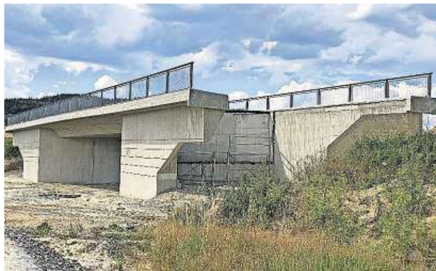
Eine der vier Brücken, die im Rahmen des Bau der neuen Rötzer Ortsumfahrung entstehen, führt über den Zellweg.
